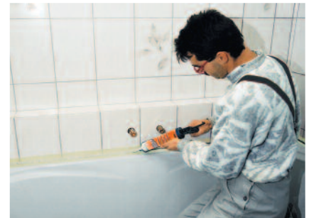
Elastisches Schließen von Fugen mit PCI Silcoferm VE; Farbtöne sind an die zementären Fugenmörtel angeglichene.
